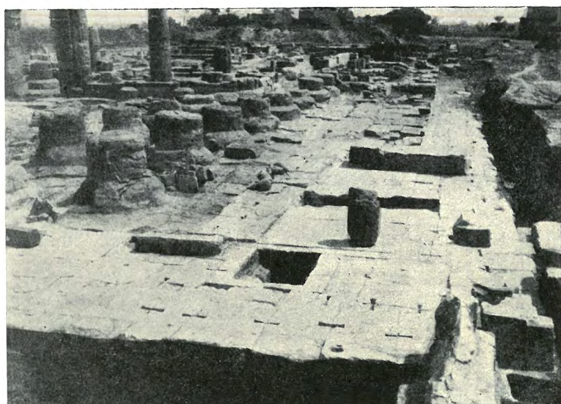
Fig. 8. — ENTRÉE DE LA CRYPTÉ AU PREMIER PLAN ET PARTIE SUD DE LA GRANDE COUR, VUE DE L'OUEST AVEC LA PIERRE D'ANGLE SUD-OUEST DU MUR-PYLÔNE EN PLACE.
